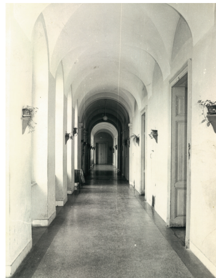
Ходник зграде Гимназије, око 1960. [ИАСо, Збирка фотографија, инв. бр. 9922]
